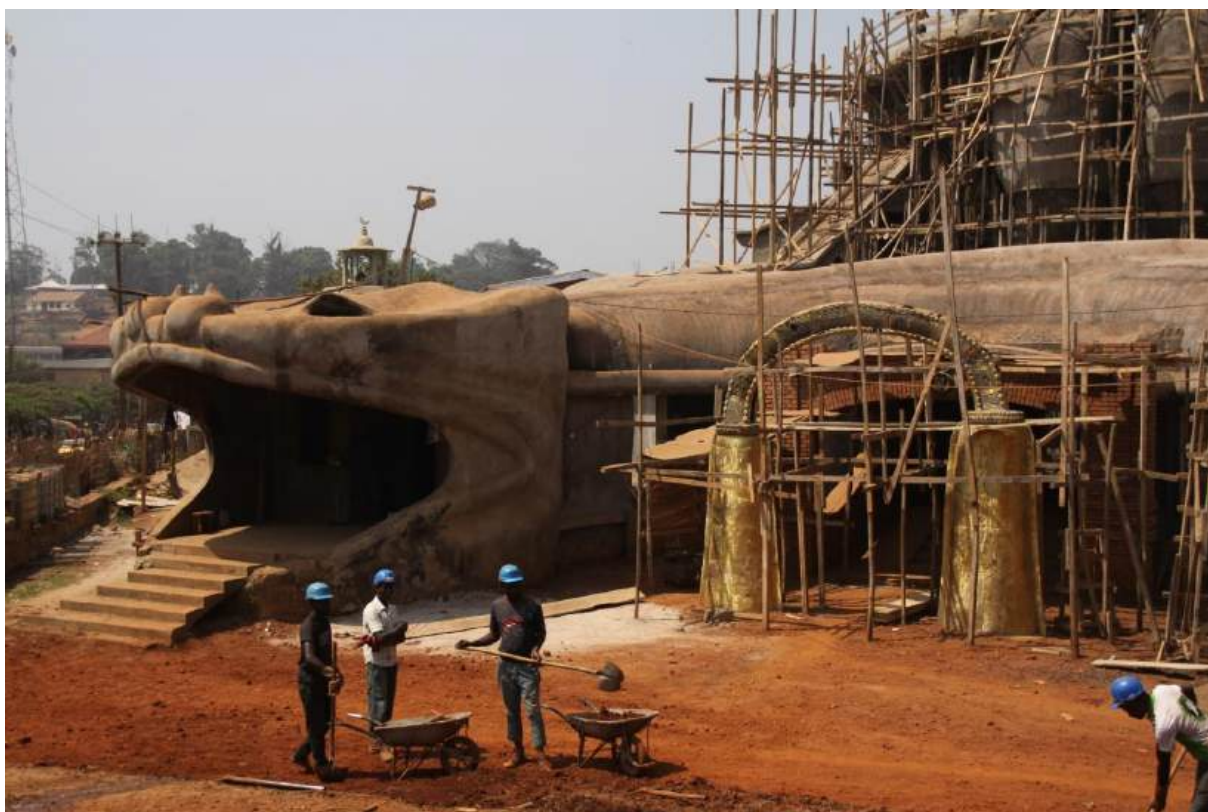
Ilustracja 4 , Plac budowy nowego budynku The Palace Museum w Foumban rok 2016 (fot. Dariusz Skonieczko)
